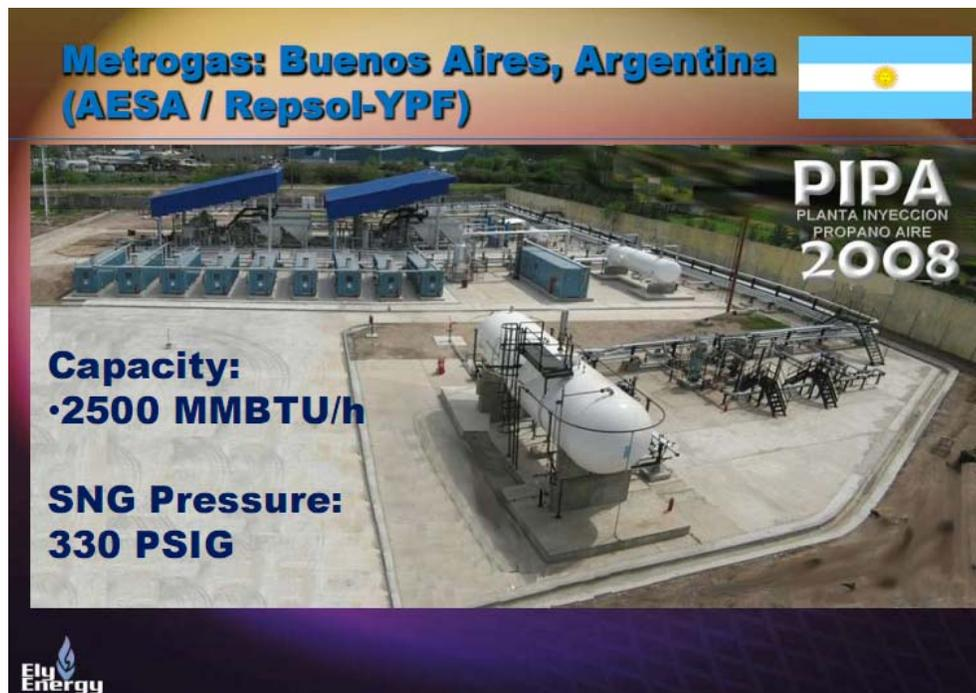
Fig. 47 – Planta de propano aire de Metrogas en Argentina
