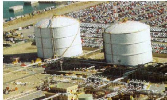
**Tanques de contención doble**
