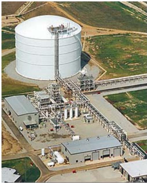
**Fig. 39 - Planta de *peak shaving* en Memphis EEUU.**
