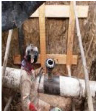
Soldadura de weldolet, niple y brida
