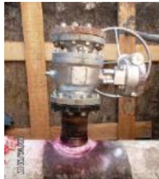
Soldadura de weldolet, niple y brida. Ver pruebas tintas penetrantes e instalación válvula con volante
