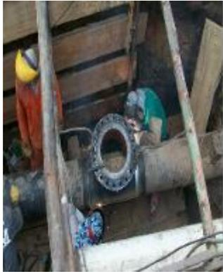
Split tee con brida. Proceso de soldadura.
