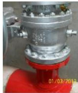
Weldolet, niple y brida. Ver pintura protectora e instalación válvula con volante
