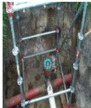
Accesorio hot tap de sacrificio, ver tubería y caja de inspección.
